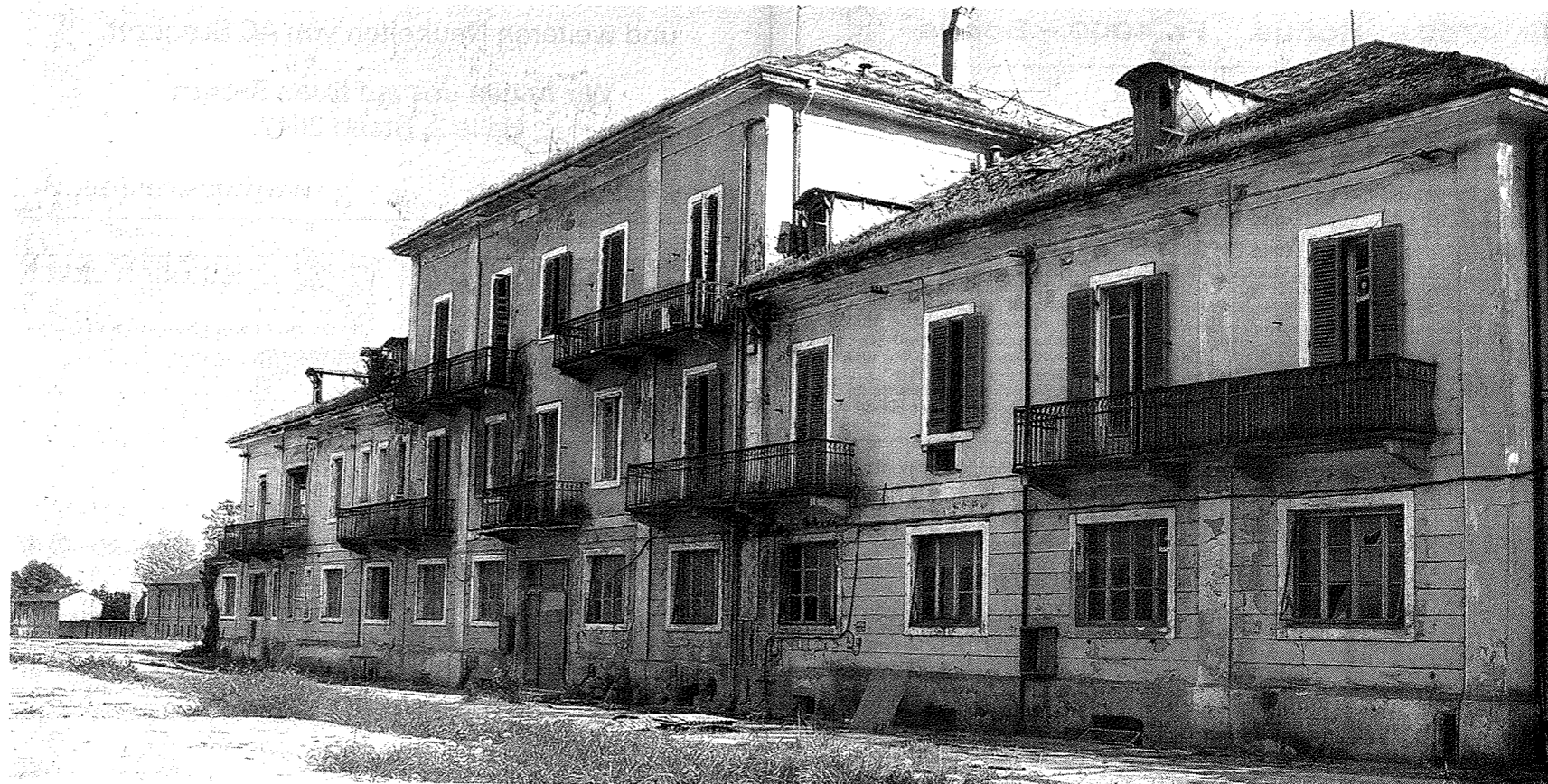
Ehemals grösste Eternit-Fabrik Italiens: In diesem Gebäude befand sich die Direktion der geschlossenen Eternit-Niederlassung in Casale Monferato. Bild Maria Roselli
