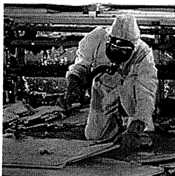
Sanierung eines Asbest-verseuchten Gebäudes (Bild key)
