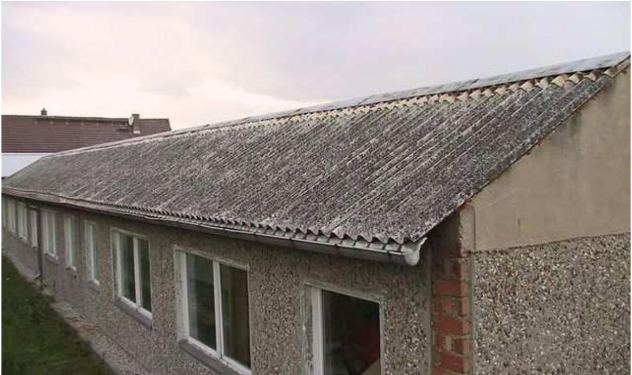
In den Entwicklungsländern gefragt: Dach aus Asbestzement-Wellplatten.
