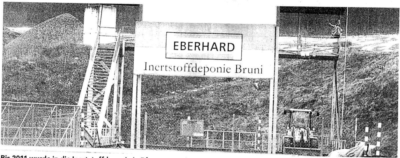
Bis 2011 wurde in die Inertstoffdeponie in Pfungen regelmässig Asbest u. a. aus dem Kanton Zürich angeliefert. Bild: gs.
